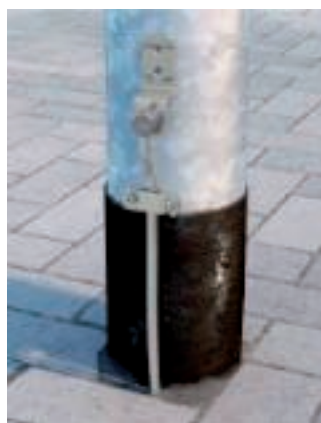
Erdung am Leuchtenmast, z. B. Beleuchtungsklasse CE5
