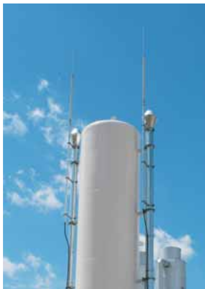
isCon®-System im Ausblasbereich einer Biogasanlage
