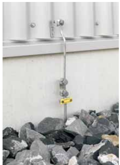
Trennstelle an Erdungs-System
