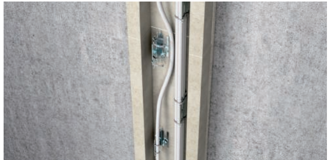
Senkrechte Kabelverlegung mittels Leitungshalter
