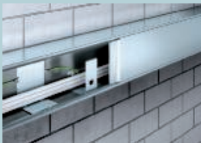
Deckelunterstützung an Stoßstelle
