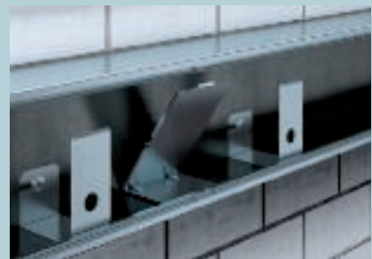
Einklicken der Bodenplatte
