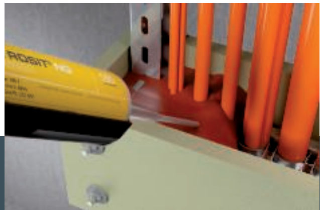
Auffüllen der Kabelzwischenräume mit Brandschutzschaum PYROSIT® NG
