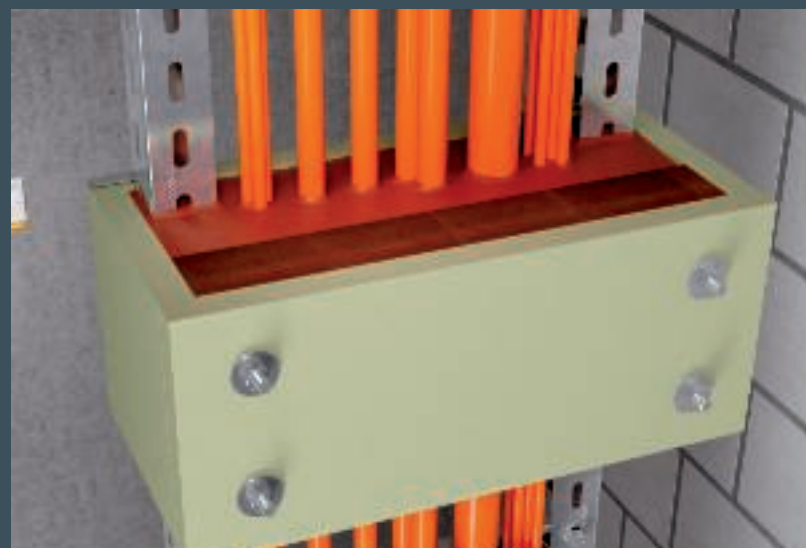
Fertig gefüllte Zugentlastung
