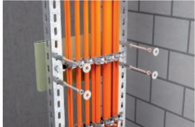
Montieren von Gewindestangen, Kontermuttern und Unterlegscheiben für die Befestigung des Gehäuses
