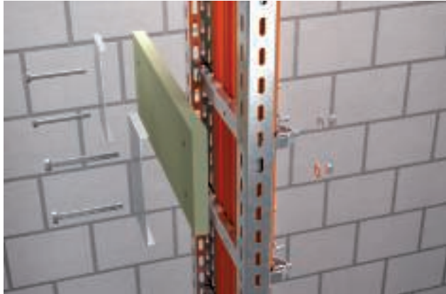
Montieren der Gegenplatte mit Sechskantschrauben an der hängenden Steigtrasse
