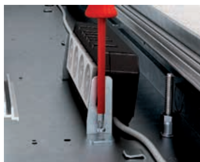
Montage Gerätebecher und Modulträger in Kanalunterteil Nach Anschluss der Installationsgeräte Gerätebecher an Modulträger oder Gerätebecher montieren. Komplette Einheit im Kanalunterteil festschrauben.
