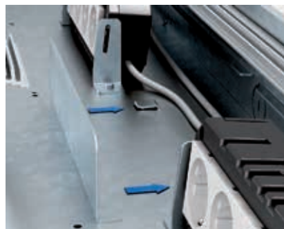
Montage Trennsteg Trennsteg erst nach Montage der fertig verdrahteten Gerätebecher und Modulträger einsetzen.
