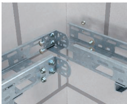
Horizontale Winkelverbinding Horizontale Winkelverbinding der Leuchenträgerschiene Typ LTS mit Längs- und Winkelverbinder Typ VF AZK.
