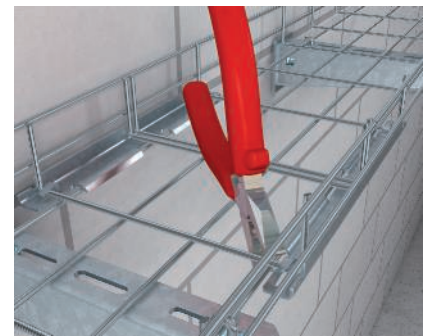
Schraubenlose Längsverbinding mit Schnellverbinder Herstellen einer schraubenlosen Längsverbinding von Gitterrinnen mithilfe des Schnellverbinders Typ GRV.
