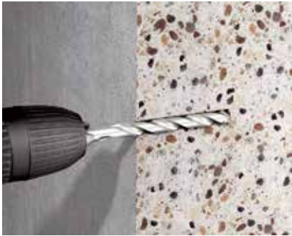
Bohren Herstellen einer Bohrung mit geeignetem Durchmesser.
