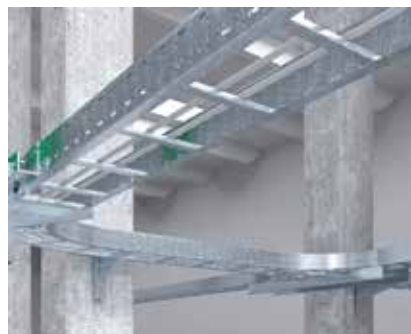
Anwendung Stahlklemmung Montage eines Weitspannsystems, geklemmt an Stahlträgern.
