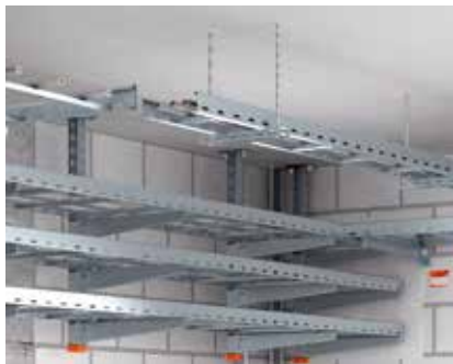
Anwendung Hängestiel- und Gewindestangenabhängung Beispiel einer Montage von Kabelleitern mit Hängestielen aus U-Profilen und Gewindestangenabhängung.
