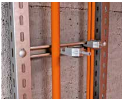
Leitungsbefestigung mit Bügelschelle Befestigung von Leitungen auf der Sprosse mit Bügelschellen.
