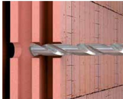
Anwendung im Hochlochziegel Loch gemäß gewählter Dübeldimension in Hochlochziegel bohren und anschließend reinigen.
