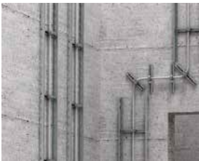
Darstellung Steigeschacht Darstellung einer fertigen Steigeleitermontage.
