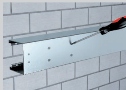
Durchstechen des Brandschutzgewebes im Bereich der Bodenlochung.
